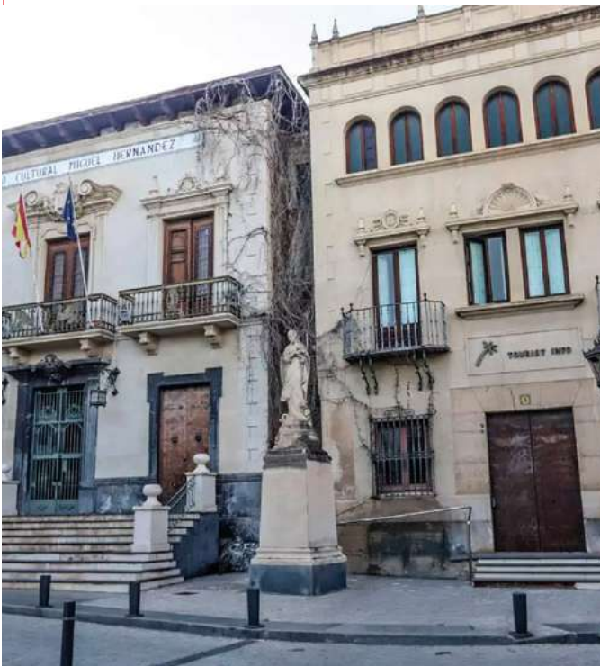
Antigua sede de la Caja de Ahorros de Ntra. Sra. de Monserrate. Orihuela Sistema Instalado: KXZ (VRF)
