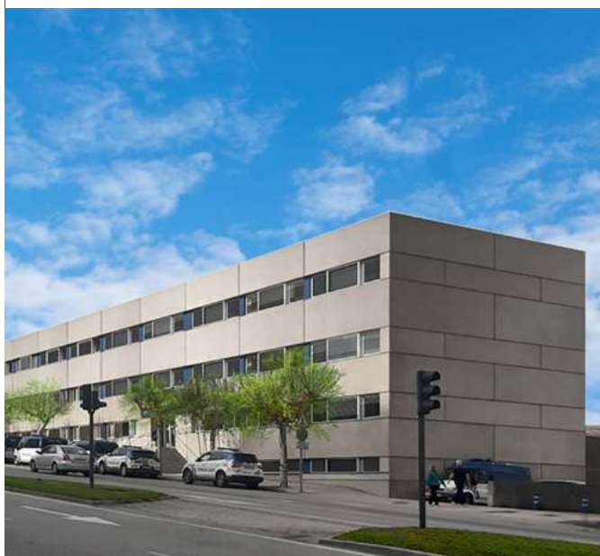
Sede de la Policía Local y de Bomberos. Burgos Sistemas Instalados: KXZ (VRF) + LMF
