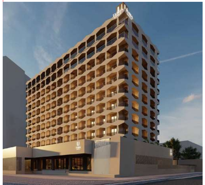
Hotel Turia Badajoz Sistema Instalado: KXZ (VRF) + Q-ton + HYDRO-ton HT
