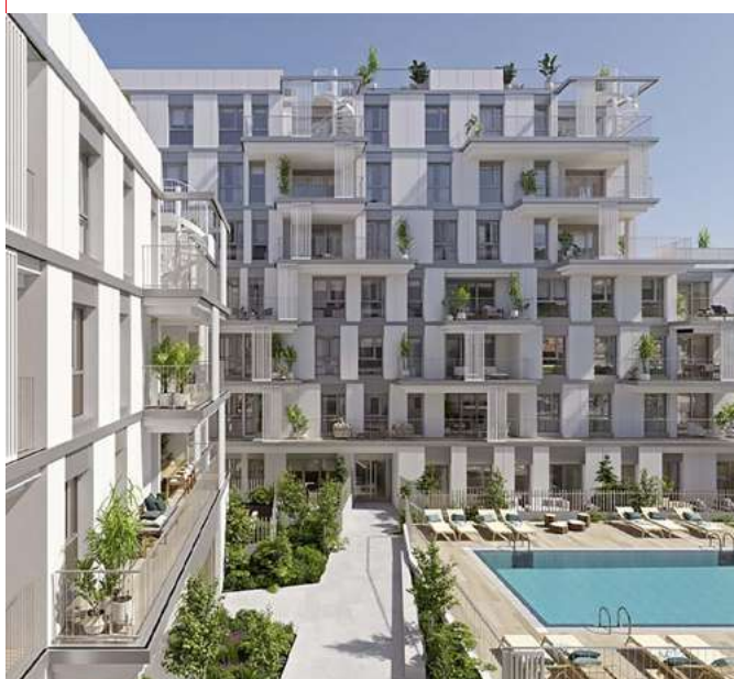
Edificio Residencial Llevant 92 Anvantespacia. Palma de Mallorca Sistema Instalado: Q-ton
