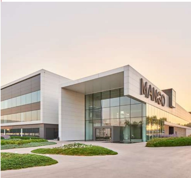
Nuevo Campus Corporativo de Mango. Barcelona Sistema Instalado: Q-ton
