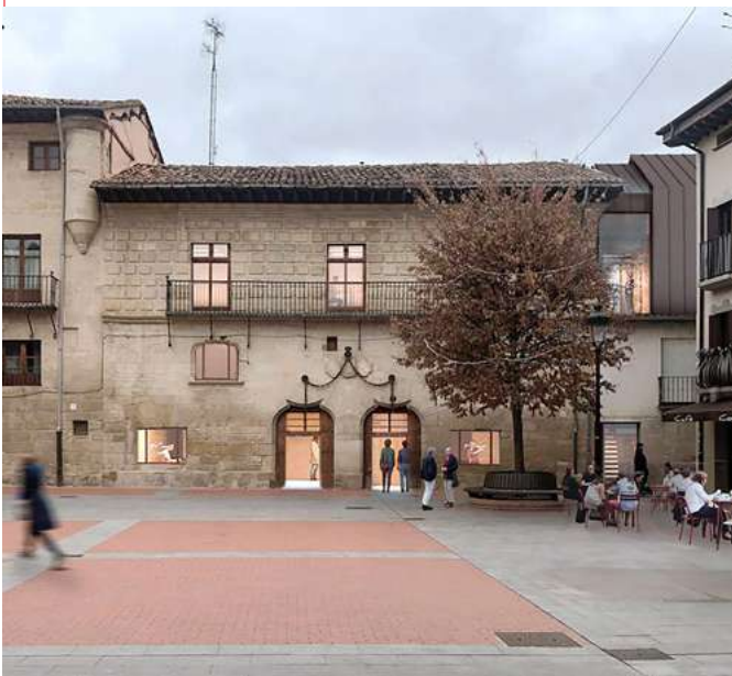
Casa de las Cadenas Miranda de Ebro. Burgos Sistemas instalados: KXZ (VRF)
