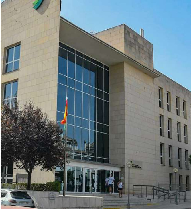
Reforma Edificio Dirección Provincial INSS de Granada Sistemas Instalados: KXZ (VRF)
